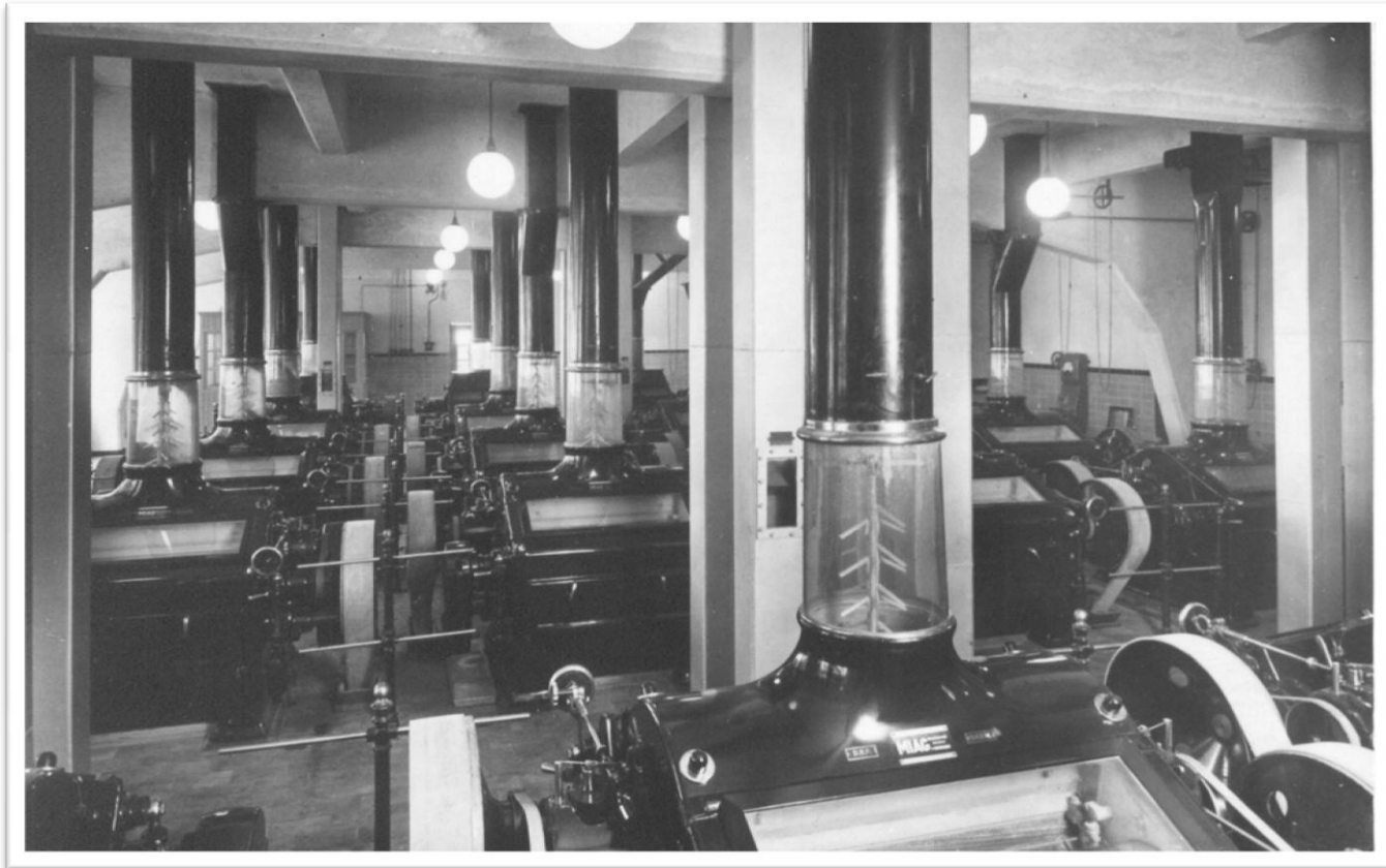
Maalderij CHV Veghel met de walsstoelen van MIAG
